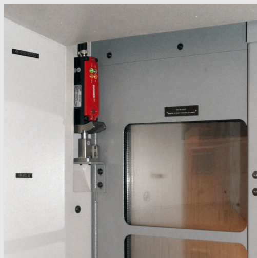
Zabezpieczenie jednych drzwi przesuwnych
